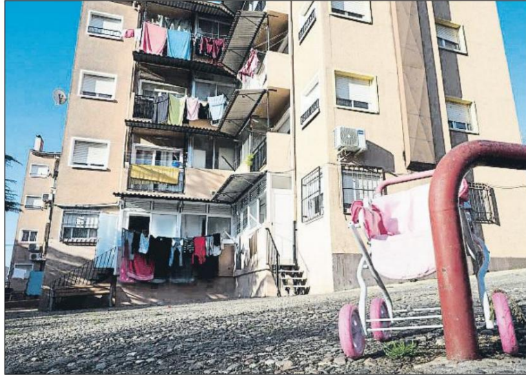
Los vecinos del barrio de Font de la Pólvera sufren cortes de luz a causa del fraude eléctrico
